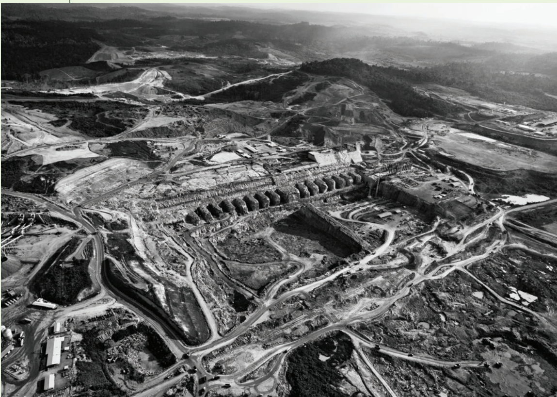
Canteiro de obra da casa de força da Hidrelétrica de Belo Monte no Rio Xingu, no Pará, em 2013 © Lalo de Almeida
